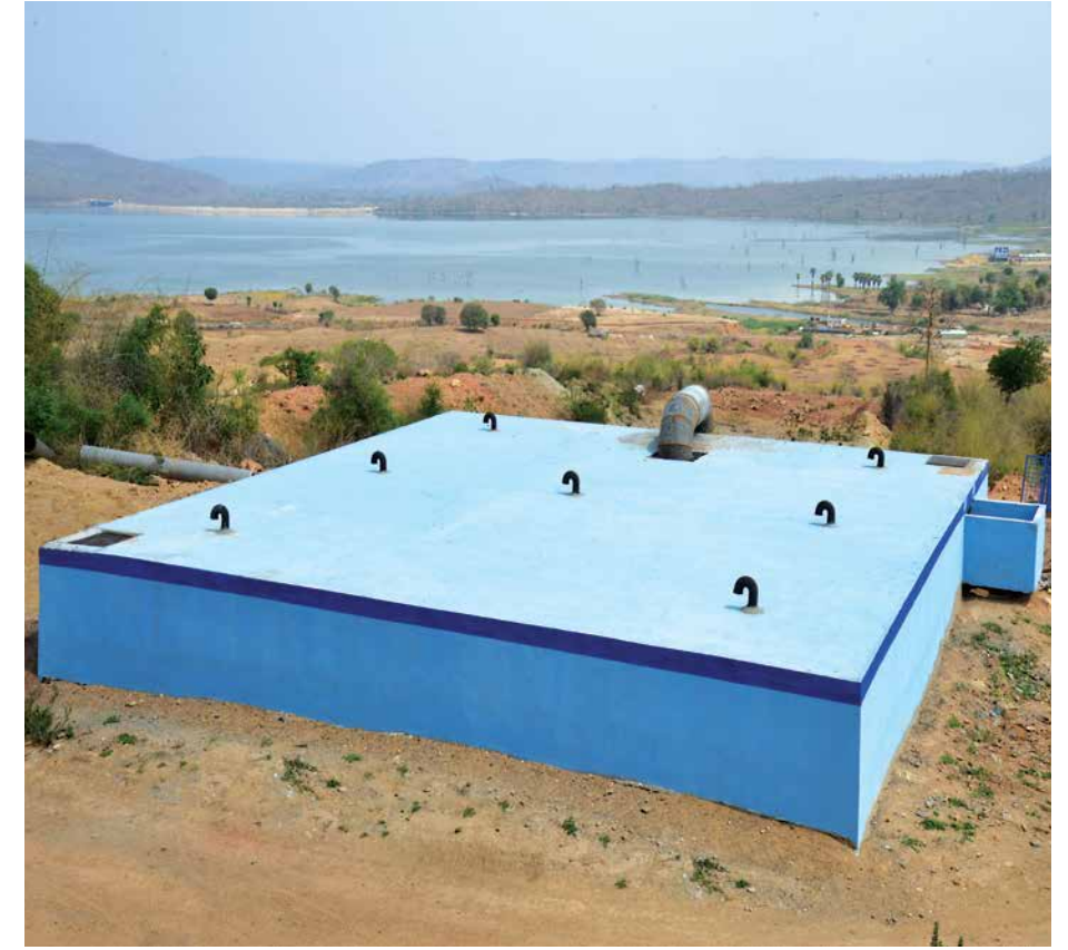
350 KL GLBR at Manikgudagutta
