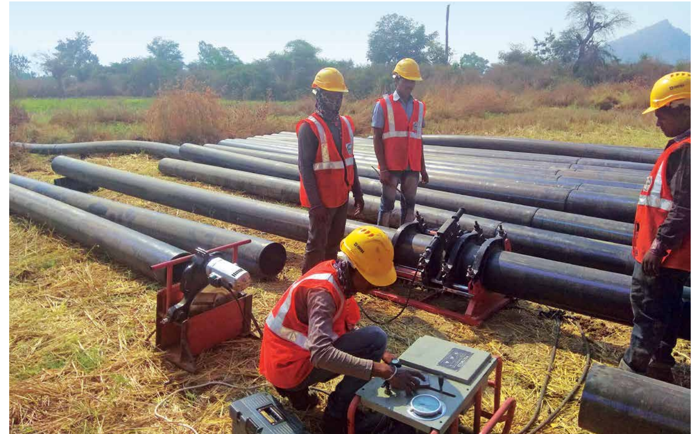
Testing the conduits
